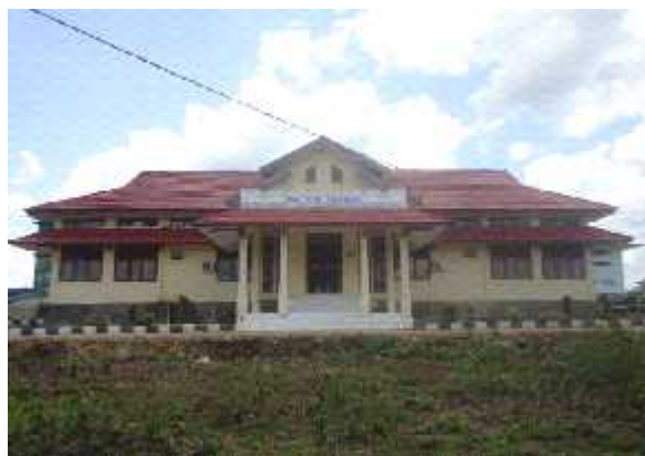
Kantor Pos POM di Baubau
